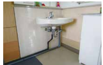
給排水の配管接続
