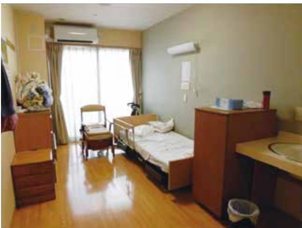
居室への機器設置の状況
